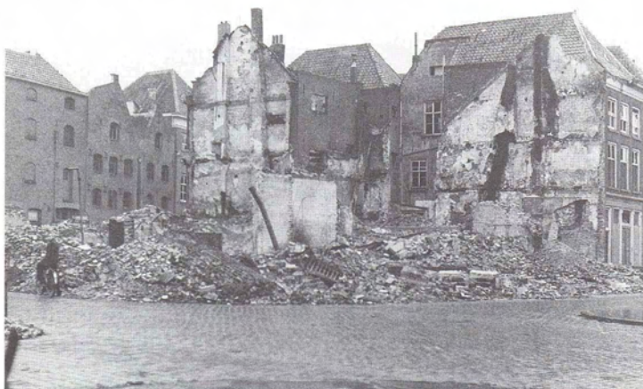
afb.2 Schade in de Visstraat tussen de Karrenstraat en de Kruisstraat (Foto: Stadsarchief 's-Hertogenbosch, Historisch-Topografische Atlas, stamboeknr. 21913)
